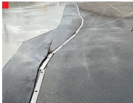
Die neue Bewässerungsanlage finanziert durch den Bußgeldsammelfond.
